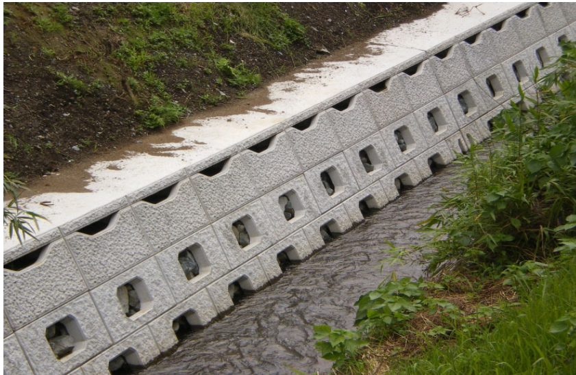
熊本県 玉岡井手地区水路
